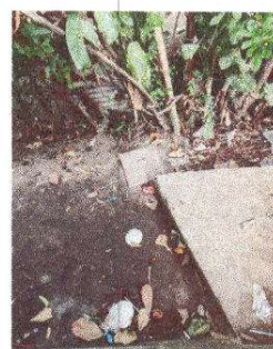
Sustrución 6: Mantenimiento a caja de registro
