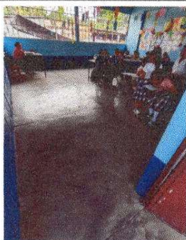
Foto 7: Sustrución de piso de granito
