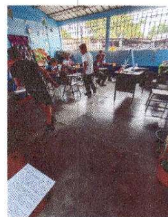
Foto 8: Sustrución de piso de granito
