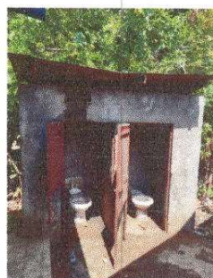
Foto 4: Sustrución de inodoro
