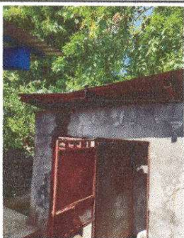
Foto 1: Sustrución de lámina, por lámina troquelada aluzinc calibre 26
