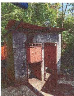
Foto 3: Sustrución de puerta en servicios sanitarios
