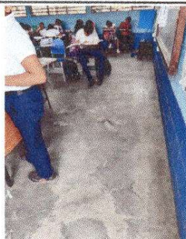
Foto 9: Sustrución de piso de granito
